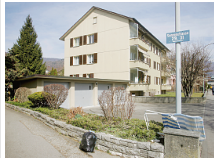
Quelque 26 coopératives ont construit à Bienne. ARCHIVES
