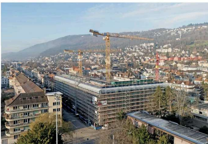
Mit dem Bauprojekt an der Dufour-/Falkenstrasse geht es nun rasant vorwärts. Die Endhöhe des Gebäudes ist erreicht. Es entstehen durchs Band Genossenschaftswohnungen.
